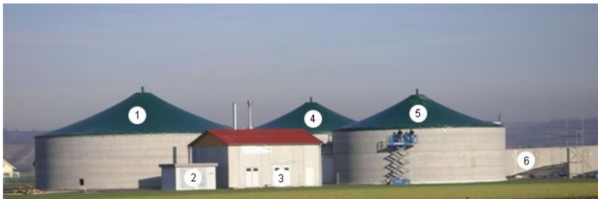
(1) Endlager (2) Trafostation (3) Heizhaus (4) Fermenter 1 (5) Fermenter 2 (6) Fahrsilo
